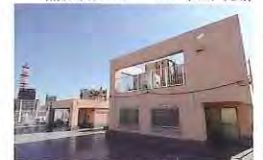
屋上防水もやり替え
